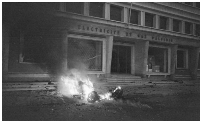
Photo 1 : Bâtiment d'Électricité et Gaz d'Algérie à Oran, cible régulière de l'OAS. cessez-le-feu (© ecpad 2012)
