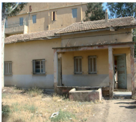
Photo 12 : BMO de Ksar El Bouhari, wilaya de Médéa, s. d. (MTAS, 2012)
