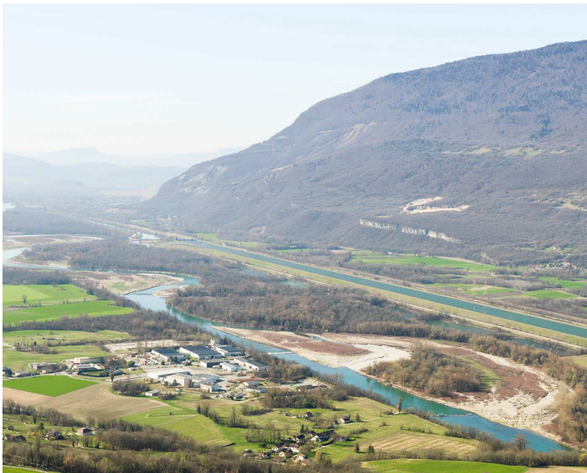
Figure 59 — Vue sur le Rhône en Chautagne depuis Motz, avec le Vieux Rhône sur la gauche et le canal de dérivation, rectiligne, sur la droite (source : Bruno Cagnon Photographe 1 2023)
