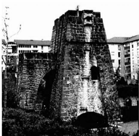
Figure 3 : Pylone support des poulies du câble téléodynamique de Bellegarde - 1873.
