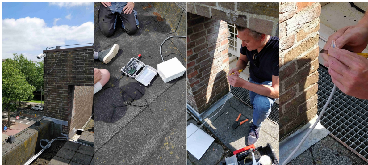
Figure 7.8 : Réparations sur le toit à l'entrée du Marineterrein
