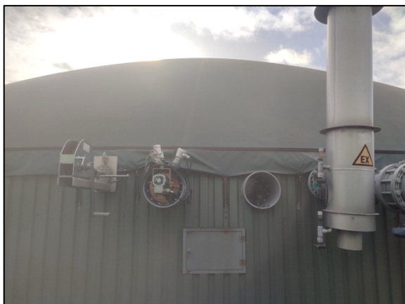
Figures 3 et 4. Les équipements de contrôle de la qualité du biogaz (présence de sulfure) installés au sommet de chaque digesteur.
