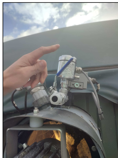
Figures 3 et 4. Les équipements de contrôle de la qualité du biogaz (présence de sulfure) installés au sommet de chaque digesteur.
