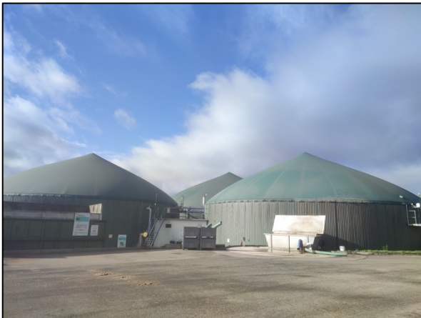
Figure 1. Les trois digesteurs de l'installation
