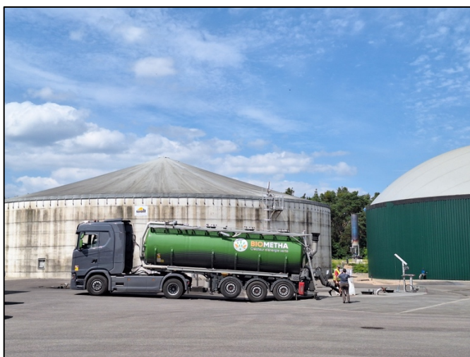
Figure 3. Camion approvisionnant l'installation de méthanisation en biodéchets
