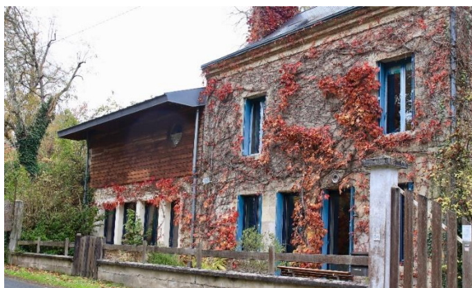
L'école de Marnay, aujourd'hui. Elle est la propriété d'un particulier. (Photo prise par Michel Verdier, in situ , en septembre 2021)
