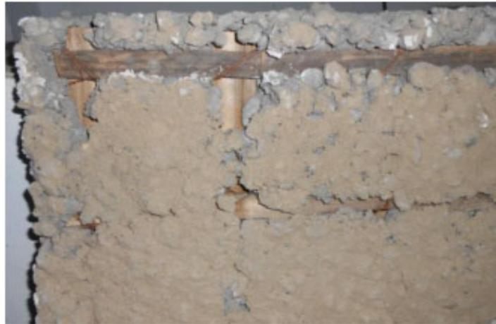
Figure 1-26: Mur armé de bambou [103]
