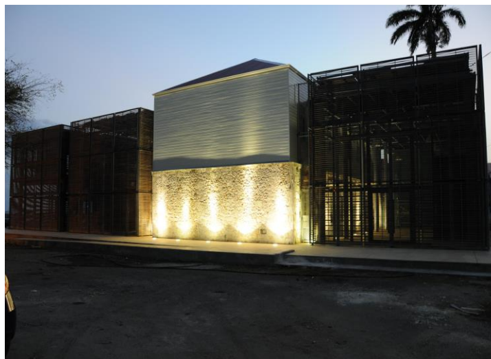
Photo 13 : Le siège de la communauté des communes à Grand-Bourg de Marie-Galante. (2007). « Trois boîtes de verre, enchâssées dans un treillis de bois, sont alignées dans le gabarit d’une vieille bâtisse du XIX ème siècle qu’il fallait préserver. » (Architecte : Pile et face). Source : Marc Jalet, 2019.
