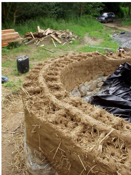
Photographie d'un mur en bauge en construction lors du chantier de Mme P. et M. B.
