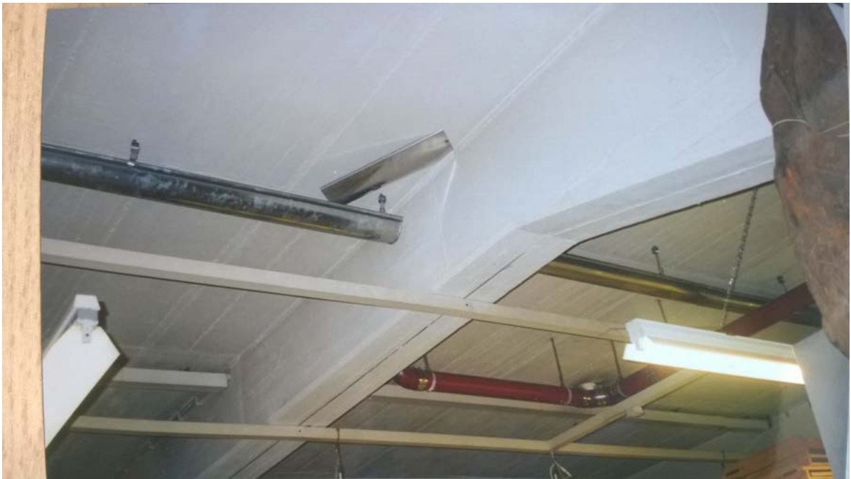
Figure 4.31 The installation of internal gutters, photograph by Hans-Joachim Radosuboff, © Ethnologisches Museum der Staatlichen Museen zu Berlin – Preußischer Kulturbesitz
