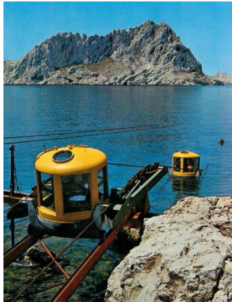
Photo n° 19 : Le télécabine de Denis Creissels © Vieux Marseille
