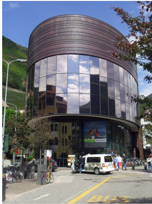
Photo n°39 : Gare aval de Bolzano. © D. Giney, 2016
