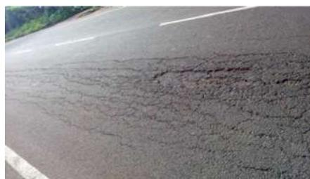
FIGURE 5.6 – Fissuration et arrachement de granulats en surface de chaussée
