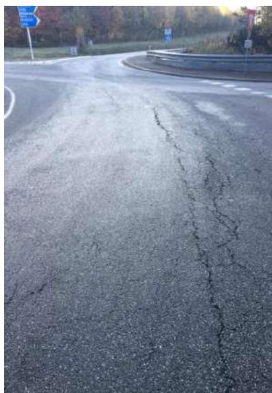
FIGURE 5.14 – Fissuration de chaussée en giratoire
