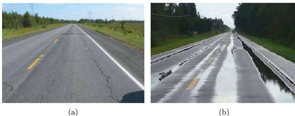
FIGURE 1.3 – Dégradation des chaussées en surface (a) fissuration, (b) ornièrisme
