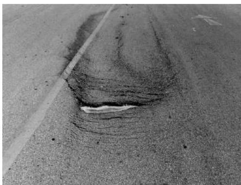
FIGURE 5.25 – Défaut d'interface, délaminage
