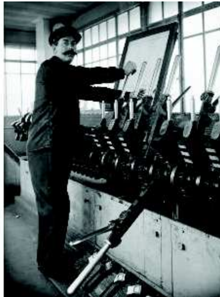
Poste 2 : aiguilleur au travail
