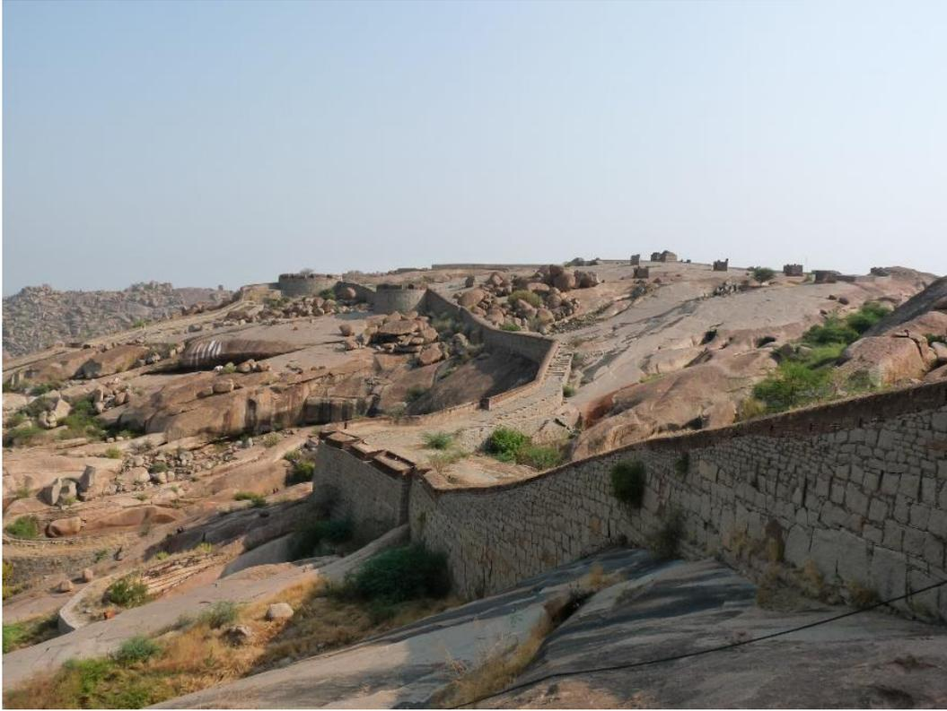
**Figure 435 : front fortifié du nord-ouest marqué par l'adaptation au relief**
