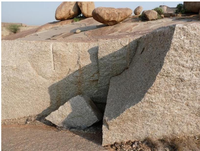
**Figure 433 : trace d'extraction de granit à Bellary**
