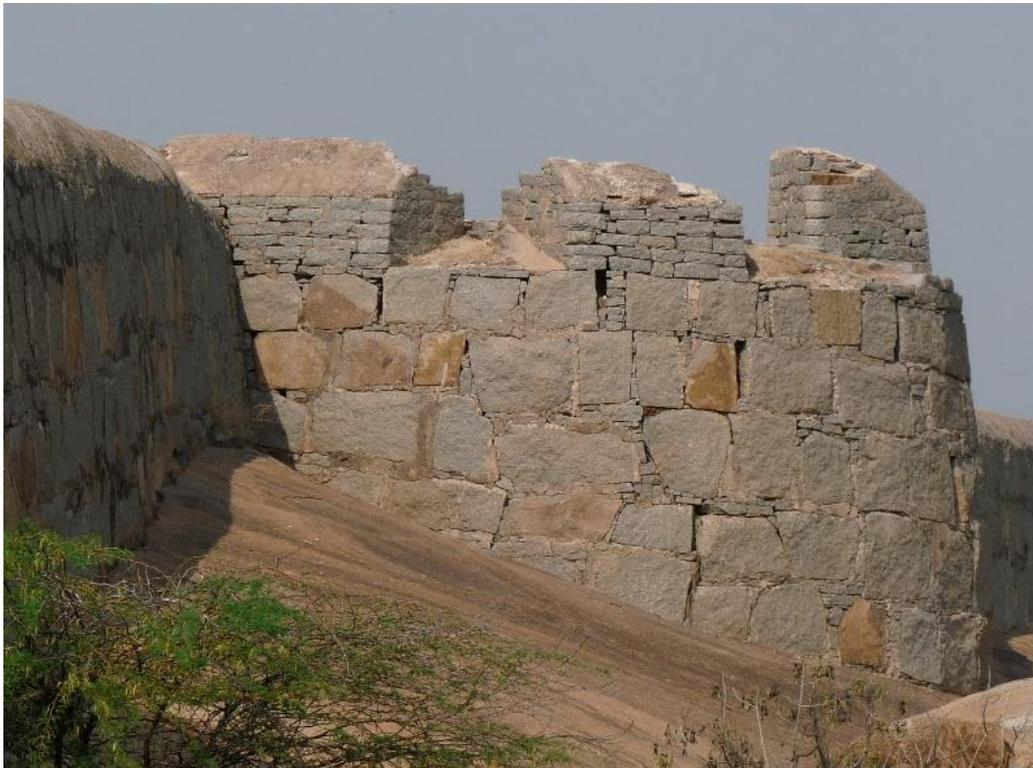
**Figure 436 : reprise de maçonnerie sur le flanc du bastion 2 et ressaut de maçonnerie entre les bastions 2 et 3 marquant un réaménagement de l'ensemble**
