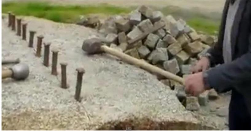
**Figure 432 : méthode d'extraction et débitage du granit**
