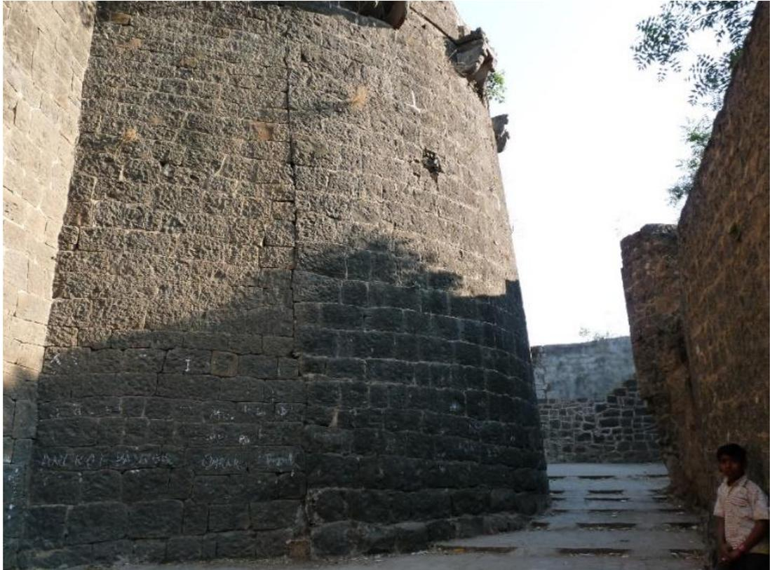
**Figure 322 : coup de sabre correspondant à l'arrachement sur la droite de la photo (P1)**
