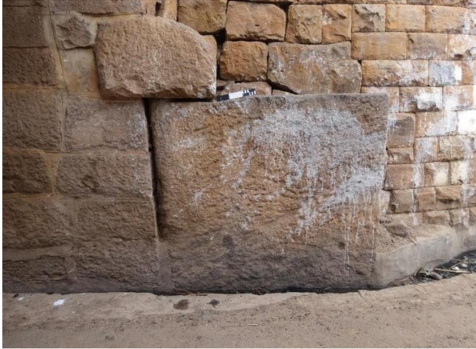
**Figure 184 : porte monolithe en pierre et sa crapaudine à la base de la porte 5c**
