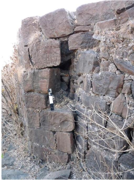
**Figure 361 : rehaussement de l'enceinte des tours 33 à 39**
