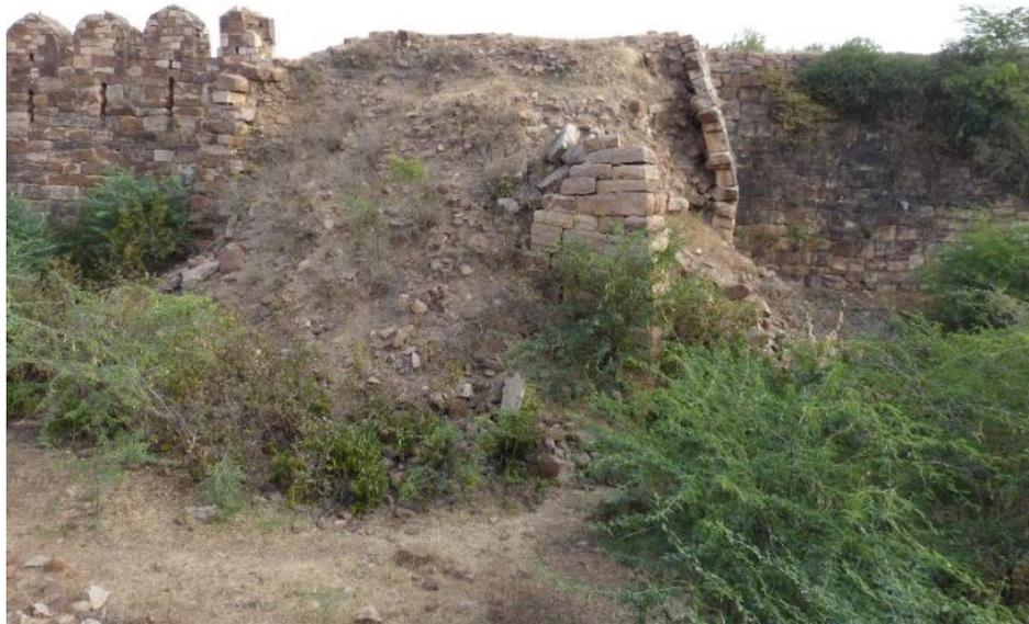
**Figure 172 : l'état de ruine de la tour 47 montre la stratigraphie des remblais et des niveaux de sols de circulation d'origine du bastion (sol légèrement chaulé) ainsi que la mise en oeuvre de la maçonnerie avec un fruit prononcé. La tour est adaptée à la circulation des archers.**
