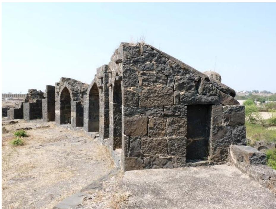
**Figure 354 : merlons casematés des bastions d'angles 14 et 67**
