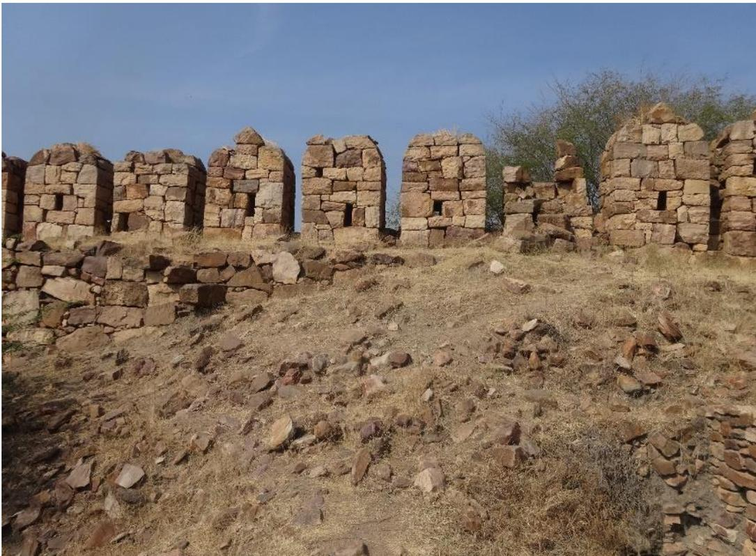
**Figure 208 : parapet Bahmani avec de simples ouvertures de tirs droit aménagées dans les merlons**
