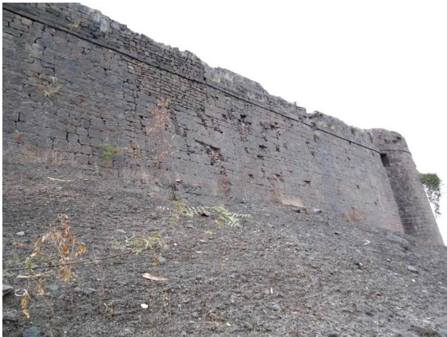
**Figure 360 : partie du front sud criblée de marques de boulets métalliques avec réparations successives.**
