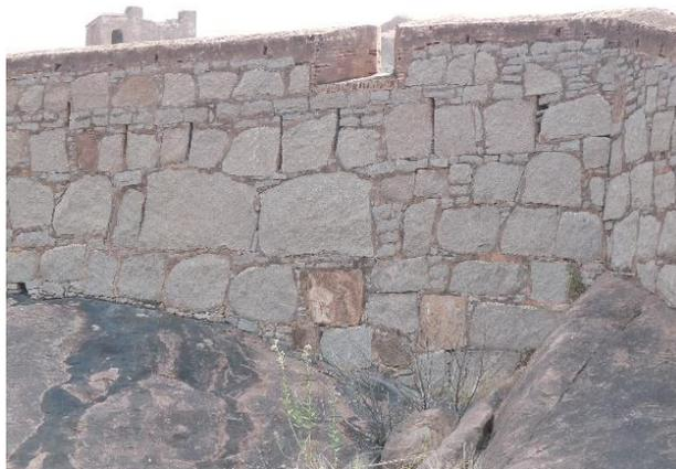
**Figure 437 : mise en œuvre hétérogène de la campagne de 1775, front fortifié du nord. Les blocs cyclopéens sont adaptés au relief chaotique à l'aide de « chandelles » de petites pierres placées entre les gros modules des assises irrégulières**
