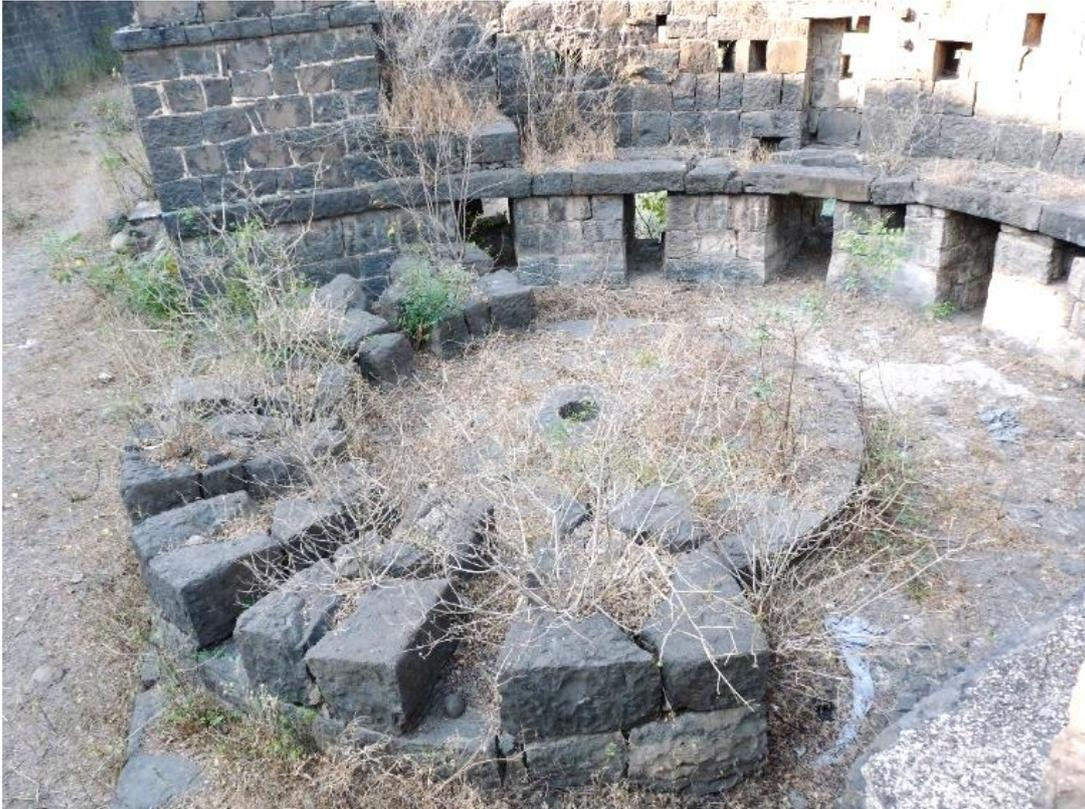
**Figure 345 : plate-forme semi-circulaire pour canon dans la fausse braie**
