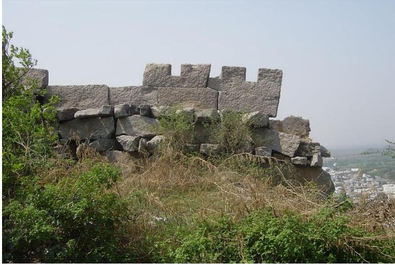
**Figure 167 : crénelage monolithique sur un des parapets du fort de Bhongir (Telangana)**
