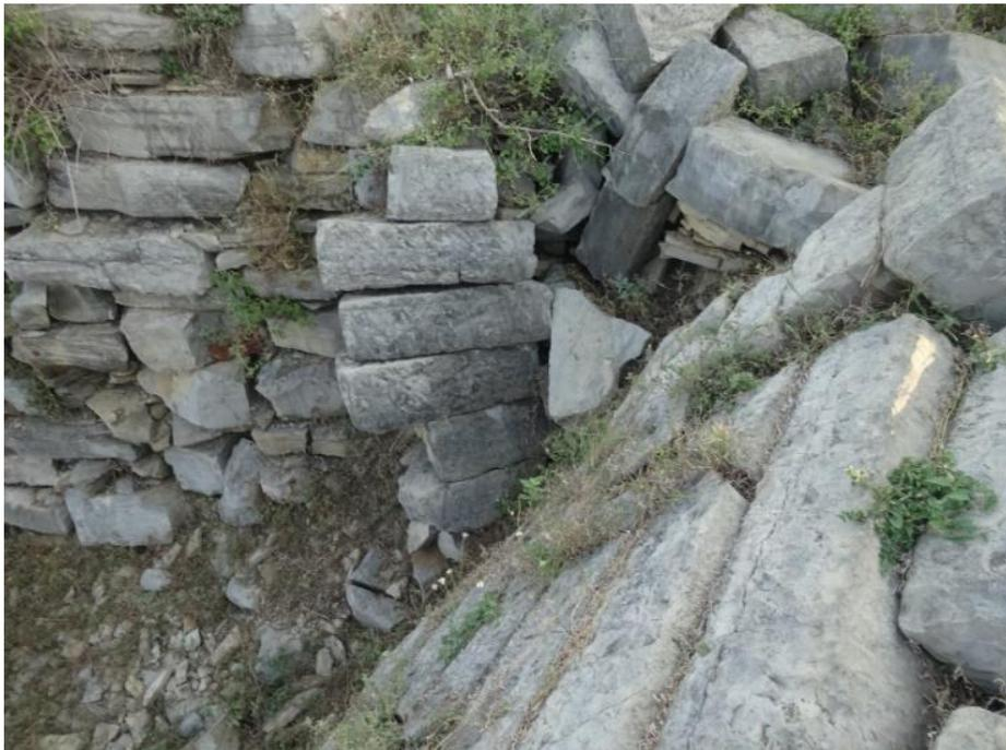
**Figure 51 : maçonnerie non chaînée et reurementage**
