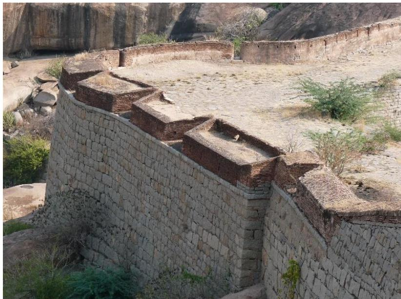
Figure 458 : parapet en caisson de brique rempli de terre de l'enceinte intermédiaire ouest (bastion 20)
