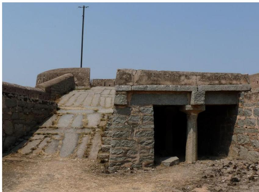
**Figure 450 : rampe d'accès pavée et aménagement de réduit à la gorge du bastion 25 de la citadelle**
