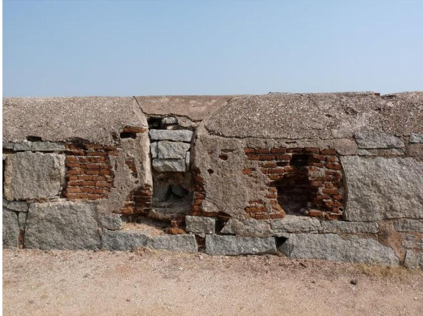
Figure 457 : crénelage bouché entre les merlons du parapet proche de la tour 2, adaptation britannique ?
