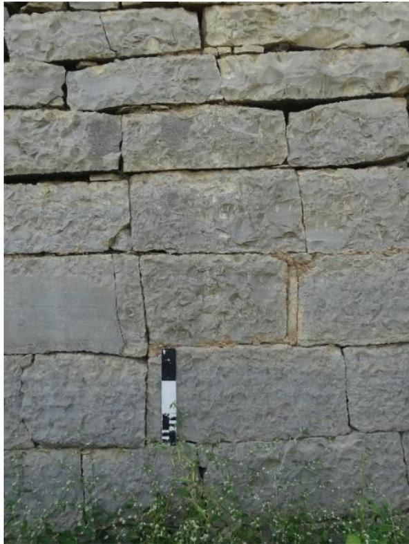
Figure 68 : détail de la mise en œuvre et des assises du parement extérieur, muraille nord
