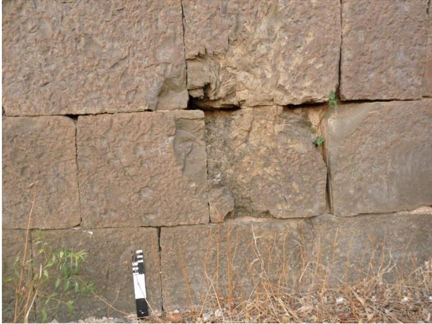
**Figure 394 : marque de boulet dans la fortification de Naldurg (front sud)**
