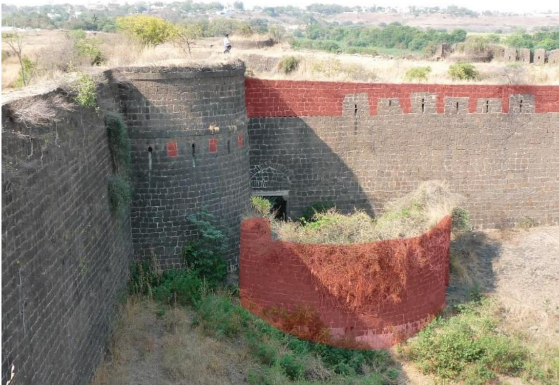
**Figure 328 : surélévation de la fortification du *Naya Qilah* et ajout de la barbacane devant P5**
