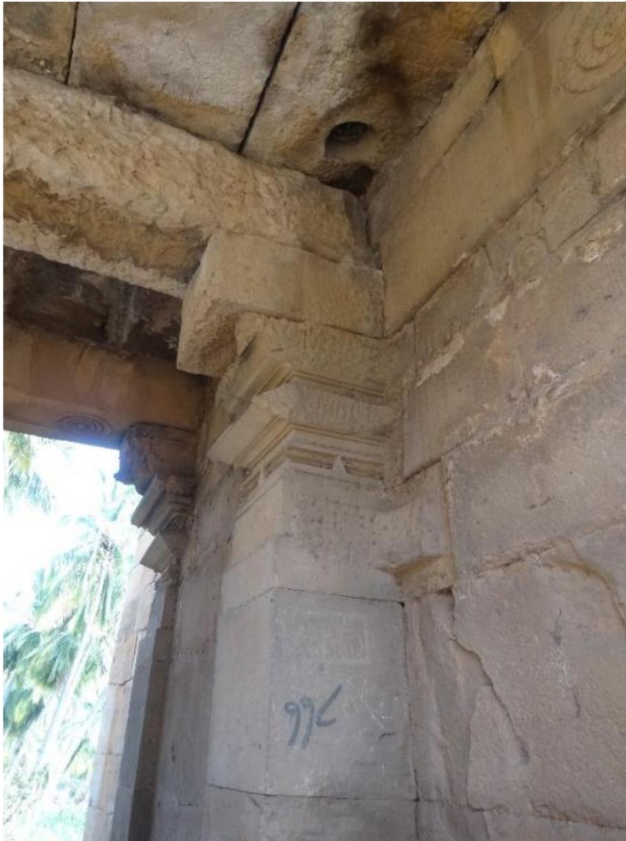
**Figure 182 : détail de la colonne modifiée de la porte 16a et de la crapaudine haute pour l'installation d'un gond d'une porte tardive**
