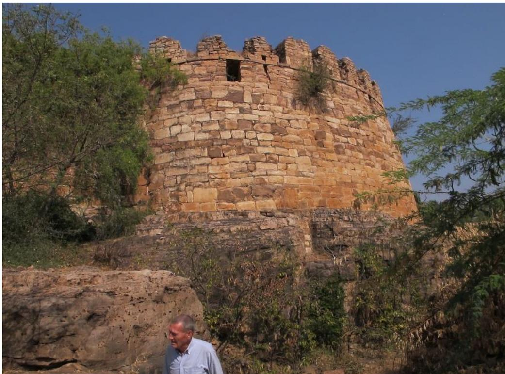
**Figure 248 : la tour 62 est construite sur le rocher aménagé en partie basse pour le canal A3 amenant l'eau depuis la rivière et la tour 35 jusqu'à l'intérieur de la cité**
