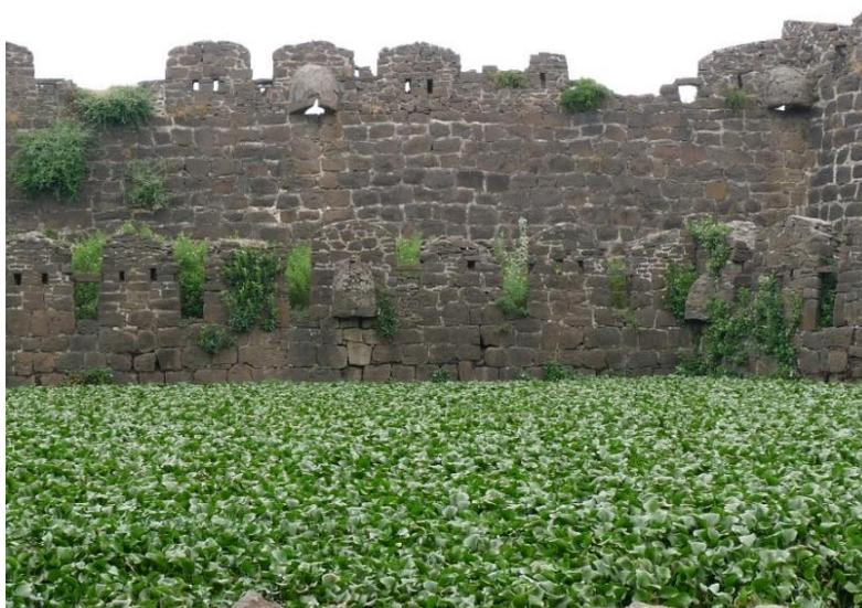
Figure 47 : deux séries de bretèche capuchon du fort de Gulbarga aménagé dans un merlon, 16<sup>ème</sup> siècle
