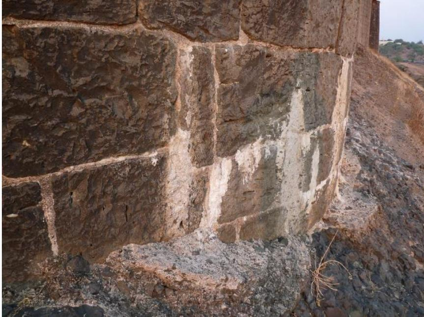
Figure 411 : coulée de chaux des joints sur la semelle de fondation (front sud de la fortification)
