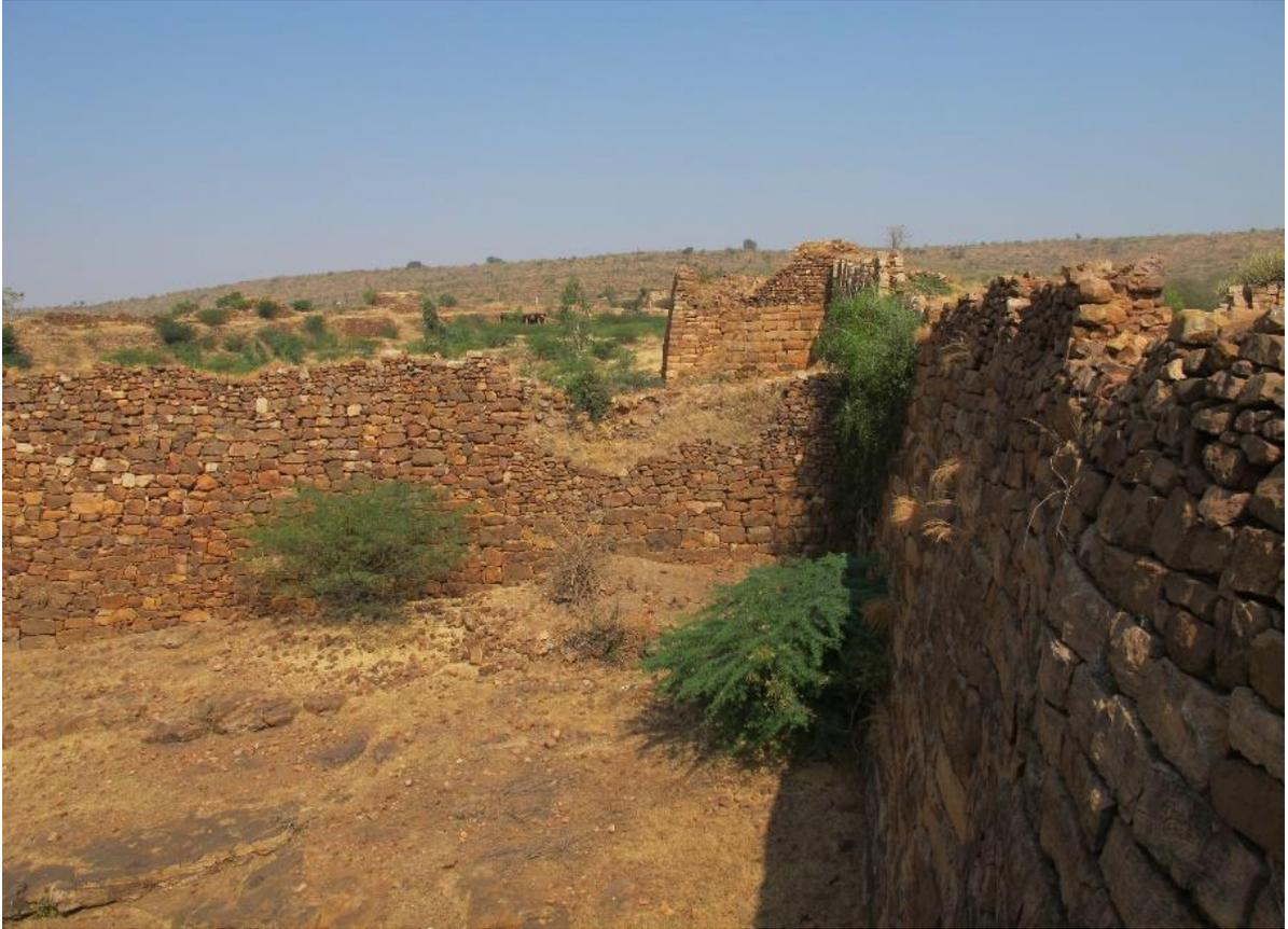
**Figure 188 : coup de sabre sur le front de la tour carrée englobée de wall II dans wall I (au centre ouest) entre les tours 55 et 28. Le sommet de la tour est bûché afin de créer un escalier pour circuler de la courtine de l'enceinte Hoysala vers la nouvelle courtine à l'ouest.**
