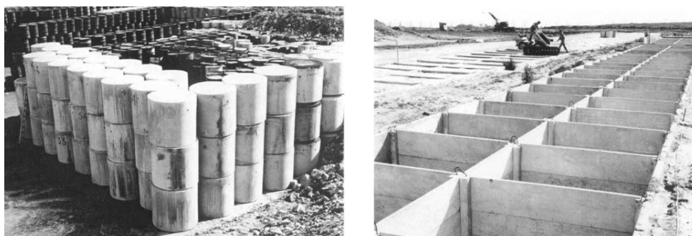
Plateforme de stockage (1971) et tranchées bétonnées (1969) (ANDRA)
