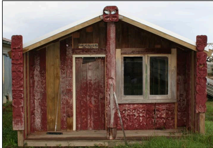
Figure 70 : La whare Rangikuruku en cours de restauration
