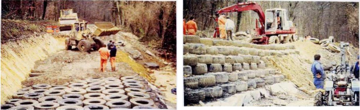
Figure I-4 : Le chantier Cannes-Mandelieu en 1988 avec la technique de Pneusol®, [Nguyen Thanh 93].
