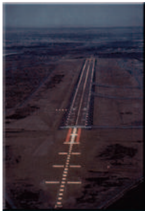
FIGURE 2.9 – Piste d'atterrissage éclairé par un système de lumières d'approche (ALS) juste avant la tombée de la nuit.
