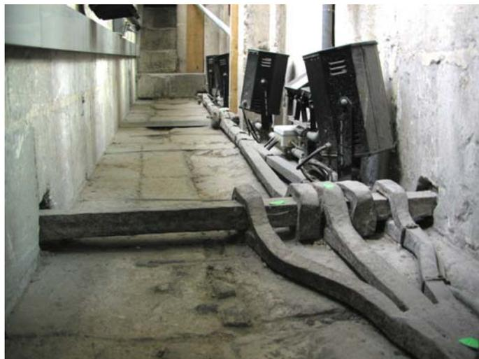
**Figure 2.24 :** a. Vue du *triforium* de la cathédrale d'Amiens et b. Ancrage du chaînage au niveau de la nef.
