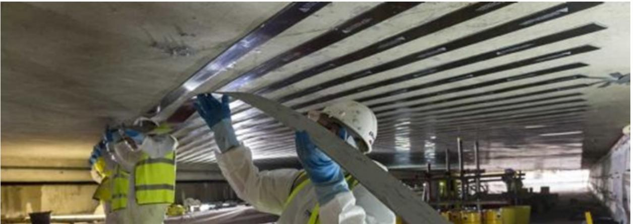
FIGURE 1 – Renforcement d'ouvrage par collage de matériaux composites [1]
