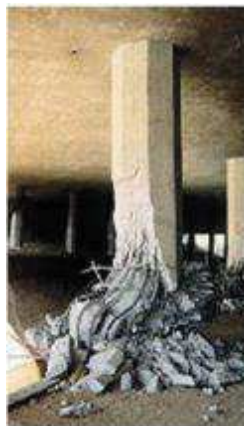
Figure I-3 : Rupture d'une pile de pont lors du séisme de Northridge 1994
