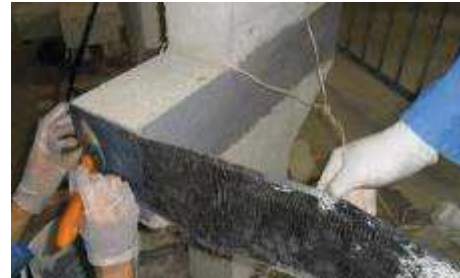
b) Application à l'aide d'un pinceau de la colle
