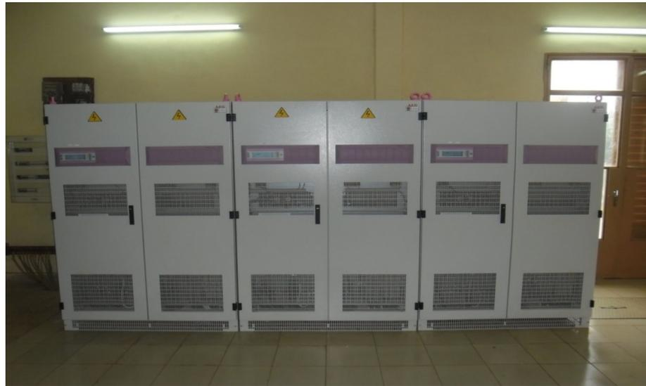
— Des batteries composées de 196 éléments de 2,5V/2000 AH
