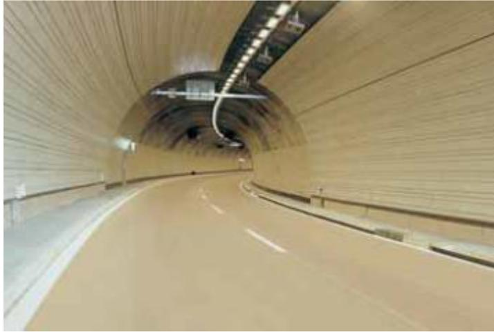
Figure 1-9 : Liant routier clair améliorant le confort visuel et la sécurité dans un tunnel [1].
