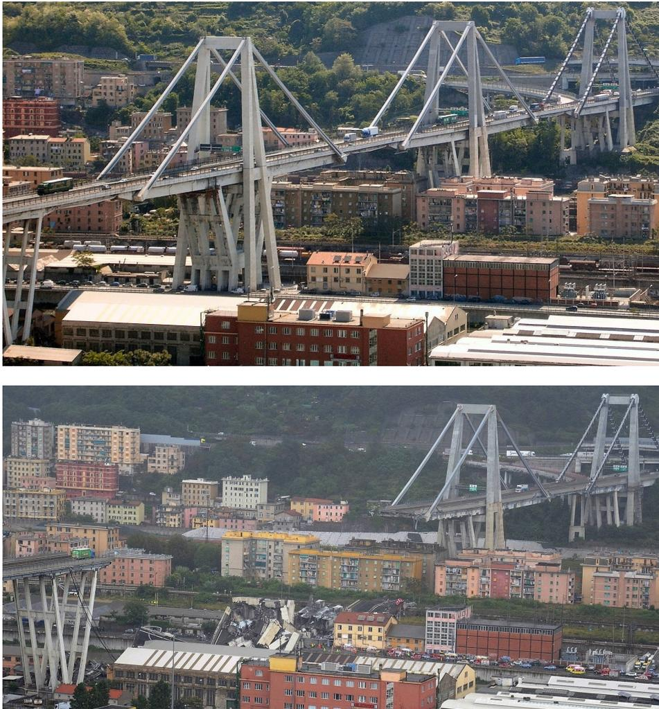
FIGURE 1.6 – Effondrement du pont Morandi à Gênes en Italie (2018)
