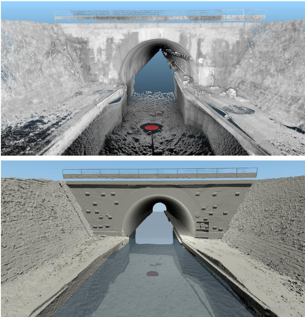
**FIGURE 4.34** – Illustrations du modèle 3D de référence de l'entrée sud du tunnel de Niderviller sous la forme d'un nuage de points (au-dessus) et d'un maillage (au-dessous). Le disque foncé au milieu du canal indique la position de la station d'acquisition du SBM.
