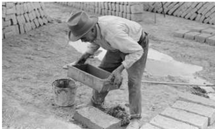
FIGURE 1-20 – Fabrication des briques de terre (Source : Rootsimple).
