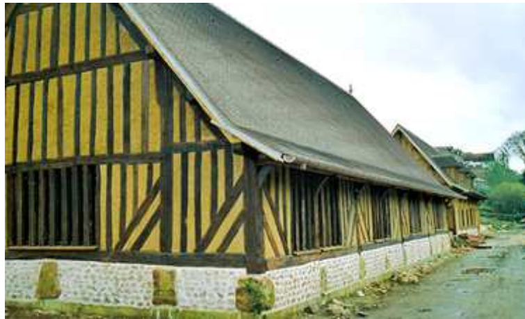
FIGURE 1-17 – Conches : musée des Arts et Traditions en cours de construction, les murs en torchis (Source : patrimoine-normand).
