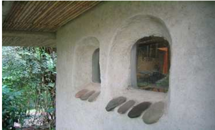
FIGURE 1-22 – Construire des murs en bauge à Abomey, (Photo Thierry Joffroy, CRAterre).
