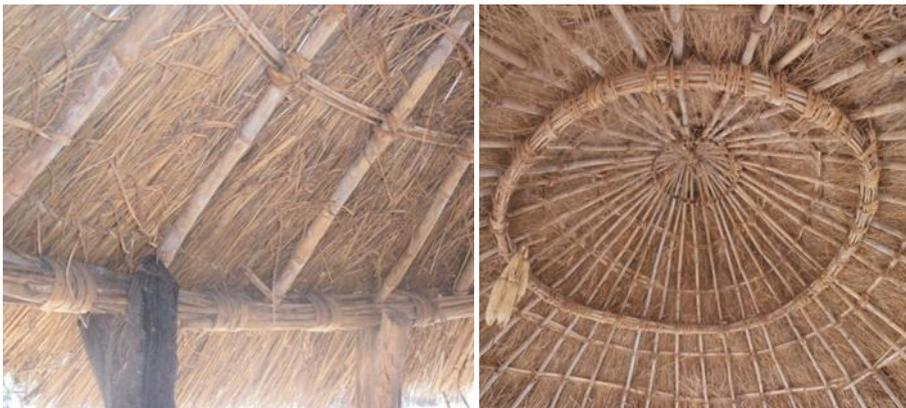
**Photos n°16 de Bambou utilisé dans la construction dans le village de Sanglé**
