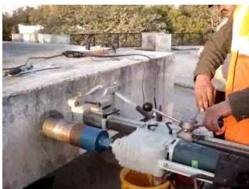
*Figure I.7 : Le carottage du béton*
