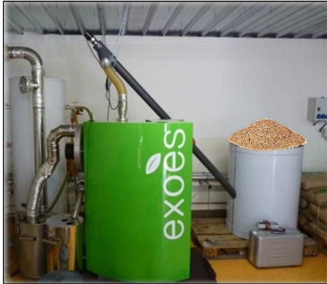
**Fig. 14.** Unité domestique de micro cogénération EXOES à cycle de Rankine à partir de granulés de bois, produisant 1.6 kWe et 16kWth.
