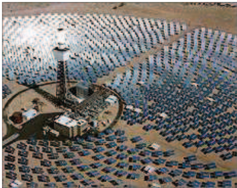
FIGURE 1.24: Photographie de la centrale solaire solar two aux États-Unis [73]
