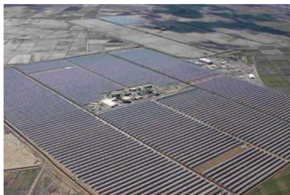
FIGURE 1.16: Photographie aérienne de la centrale solaire Andasol 1 de 50 MW e en Espagne [73]
