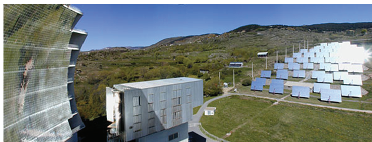
FIGURE 1.27: Photographie du four solaire d'Odeillo d'une puissance de 1 MW th [85]
