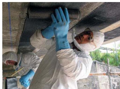
Figure III. 2 Renforcement de tablier de pont par tissu de fibre de carbone (Source Freyssinet)
