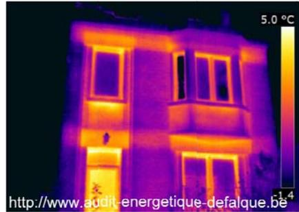
Figure I. 15. Ponts thermiques en façade d'une maison
