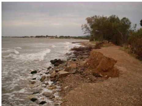
Photo 50 : Erosion du remblai (secteur de la lône).
