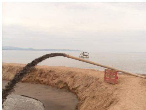
Photos 32 et 33 : Dragage et dépôt sur la plage en amont du port d'Hyères.
