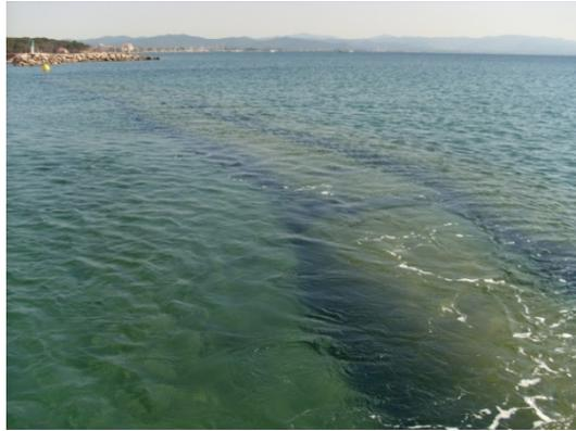
*Photo 39 : Géotubes mis en place au large de la plage de la Capte.*
