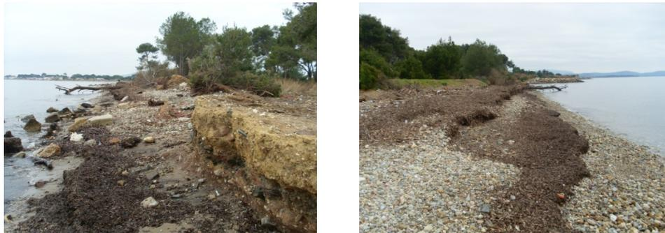
Photos 55 et 56 : Erosion du remblai et accumulation sur la berme en aval.
