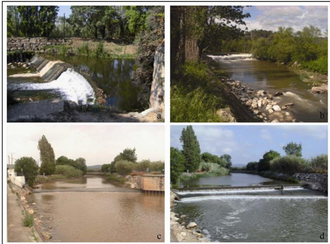
Figure 7 : Les ouvrages transversaux dans la basse vallée : a) Seuil de Ste Eulalie, b) Seuil de Ste Eulalie vu de l'aval c) Le barrage anti-sel dégonflé d) Le barrage anti-sel au module.
