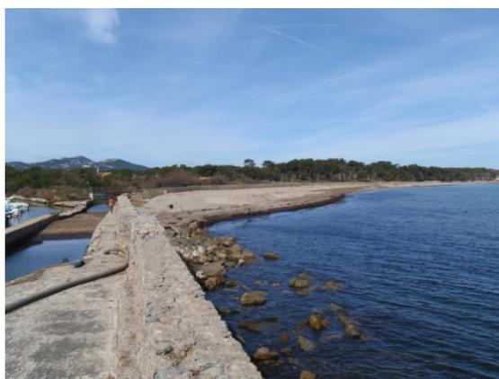
*Photo 34 : Dépôt des matériaux extraits du chenal d'entrée du port de la Capte en amont de la digue.*
