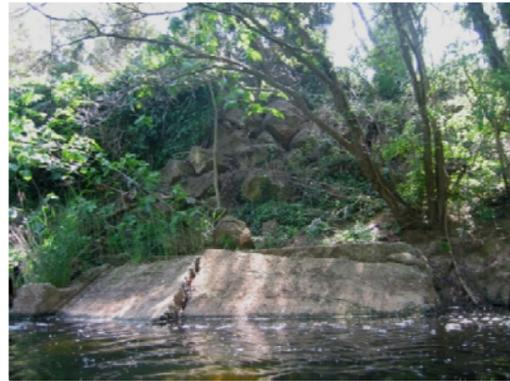
*Photos 4 et 5 : Enrochements et blocs de béton destinés à limiter l'érosion des berges en aval du seuil de Ste Eulalie.*
