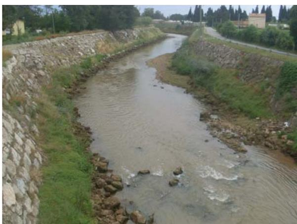
*Photo 77 : Sédiments grossiers sur le plancher alluvial en aval du pont de la D559a, rendus visibles par l'effacement du barrage anti-sel suite à un problème technique.*
