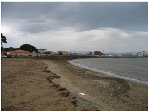
Photo 44 : Opération de dragage à l'embouchure du Roubaud et dépôt sur la plage en aval du port. Au premier plan, l'érosion du dépôt.
