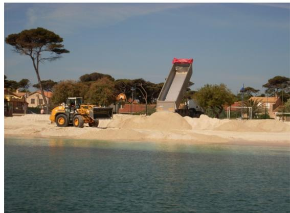
*Photos 36 et 37 : Plage de la Capte avant et pendant le rechargement.*
