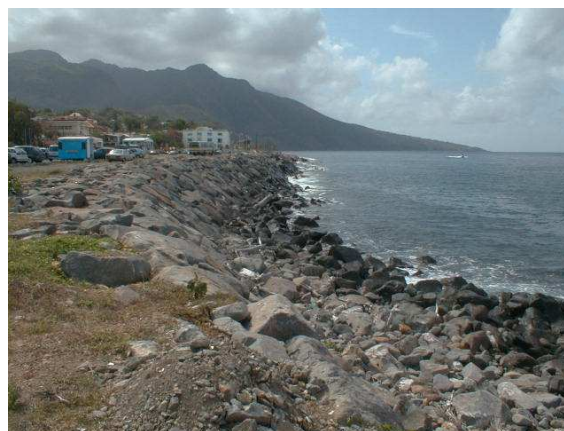
Fig. 3.1. Enrochement sur les berges près de Basse-Terre, la préfecture du Département de la Guadeloupe
