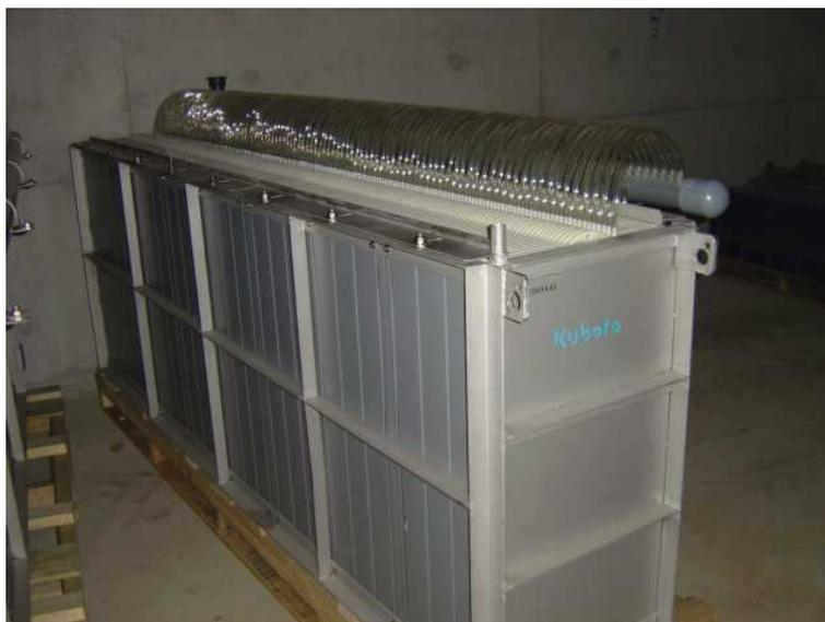
**Figure 6 : Photographie d'une cassette membranaire Kubota de la station de Le Guilvinec, avant remplissage des bassins**
