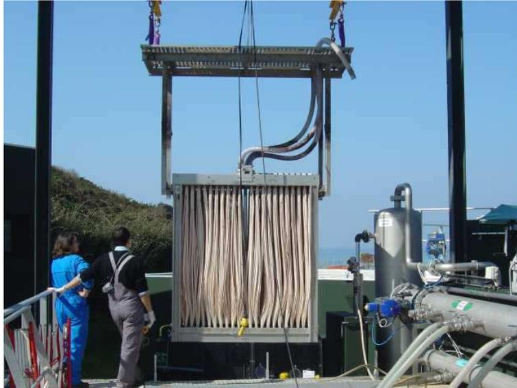
**Figure 5 : Photographie d'une cassette de membranes Zenon 500c de la station de Guéthary, sortie pour nettoyage**
