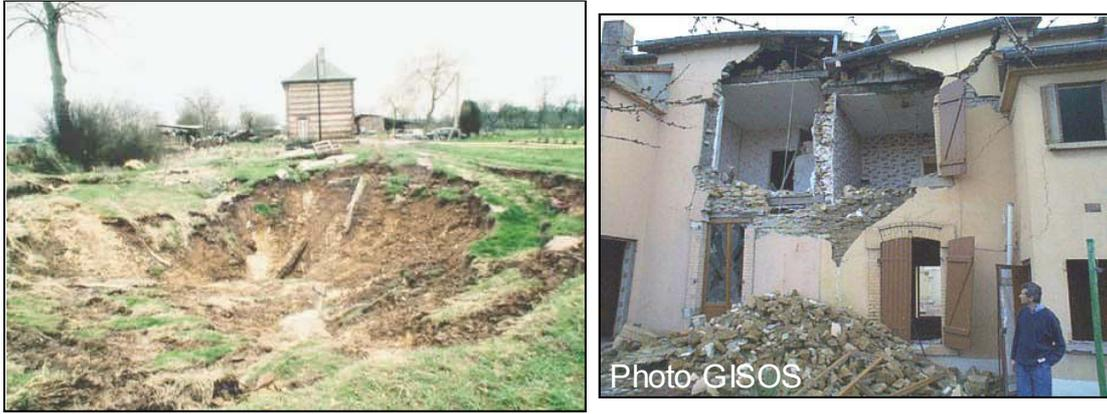
Figure 4.2 : Exemples de dégâts observés en surface dans le bassin ferrifère lorrain.
